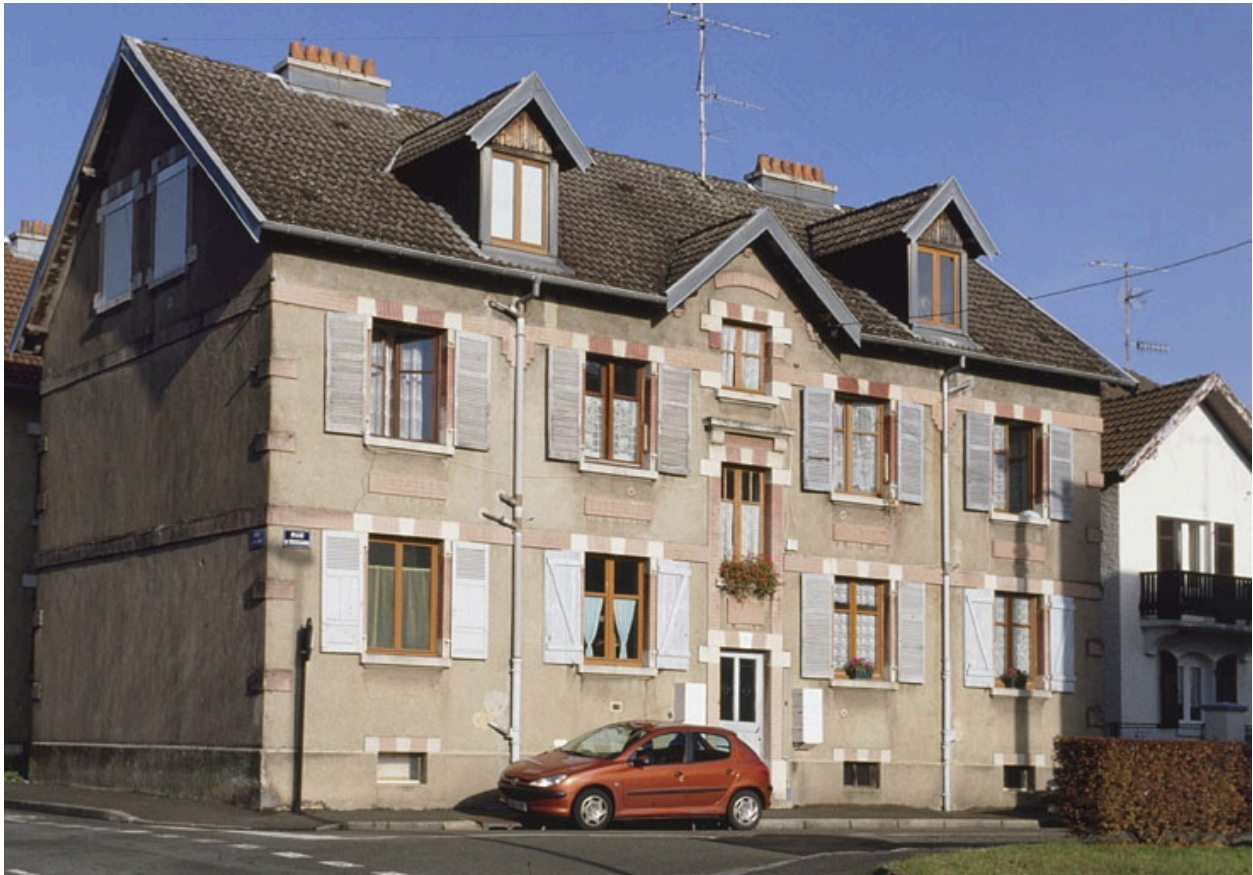
Logement ouvrier collectif à cinq travées (rue de Bussang à Belfort).
