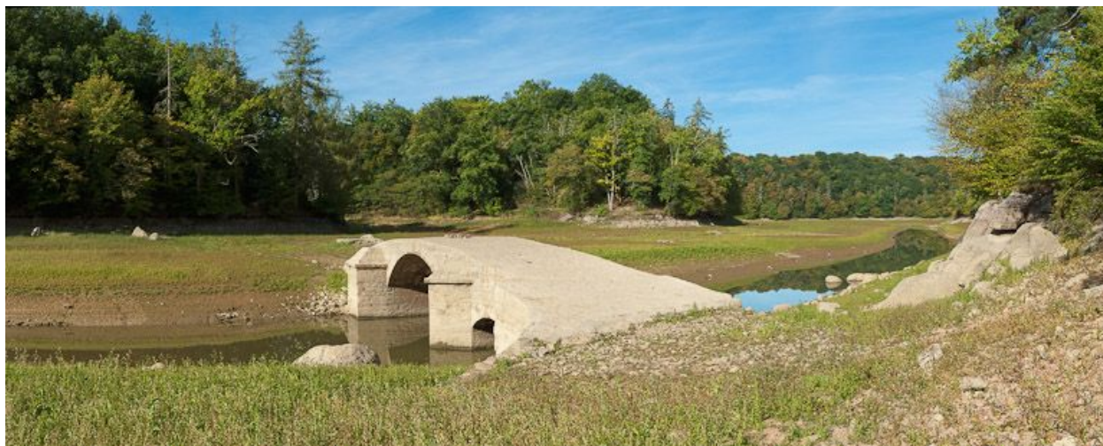
Vue du pont.
