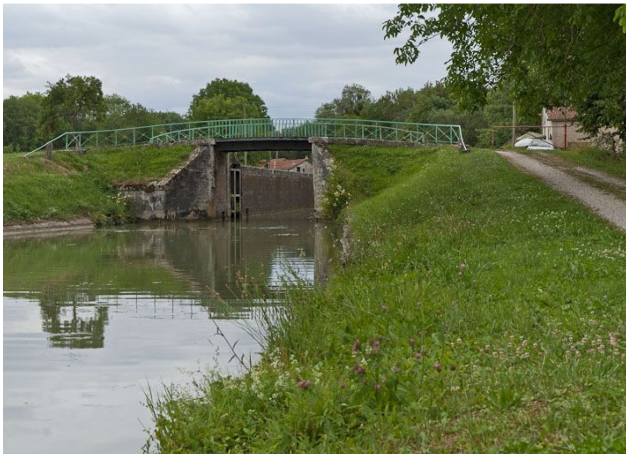
Vue du pont depuis l'aval.
