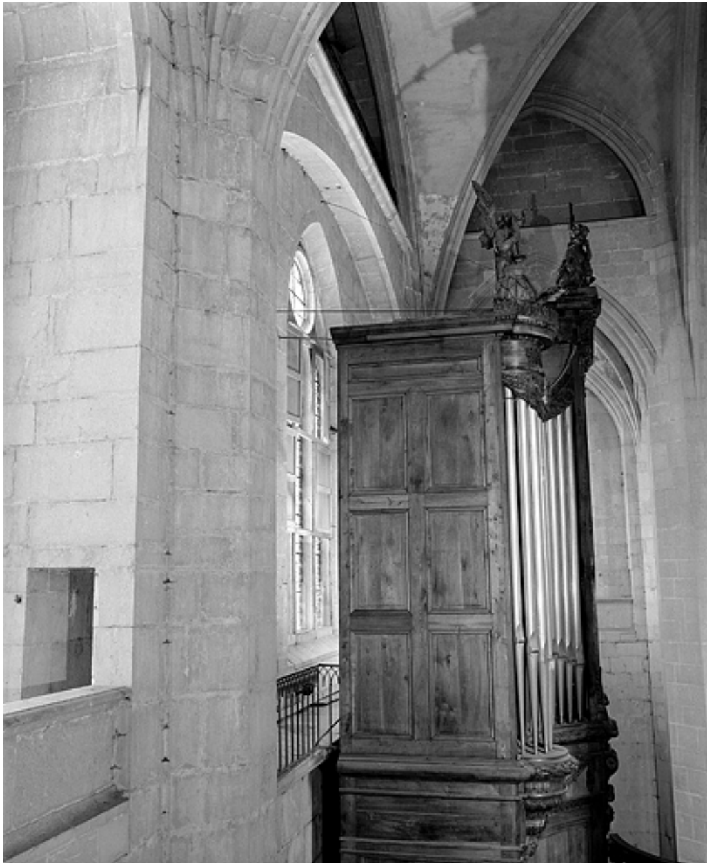
Coursière basse au revers de la façade.
