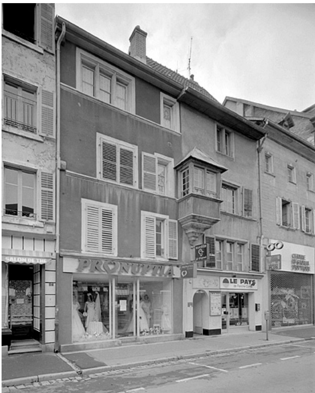
Vue d'ensemble sur la place.
