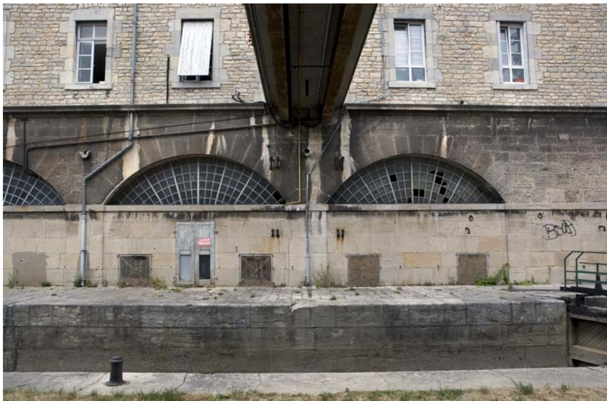
Baies des casemates, à l'étage de soubassement.
