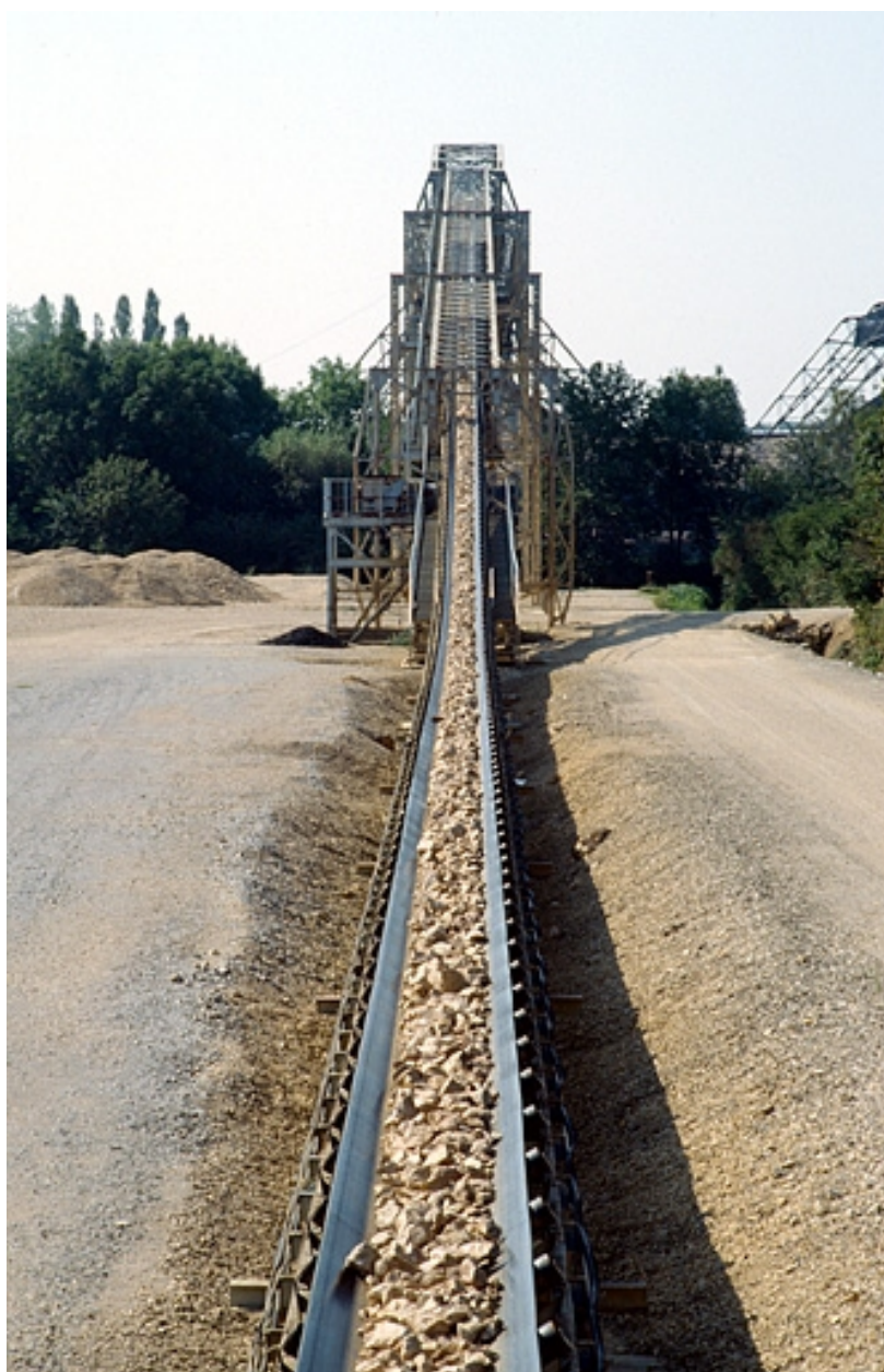
Transporteur automatique à bande et portique vus en alignement.
