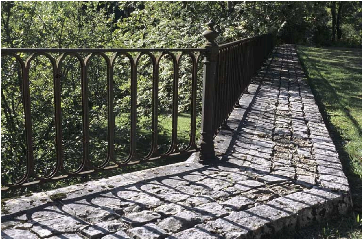
Garde-corps métallique de la cour des voyageurs.
