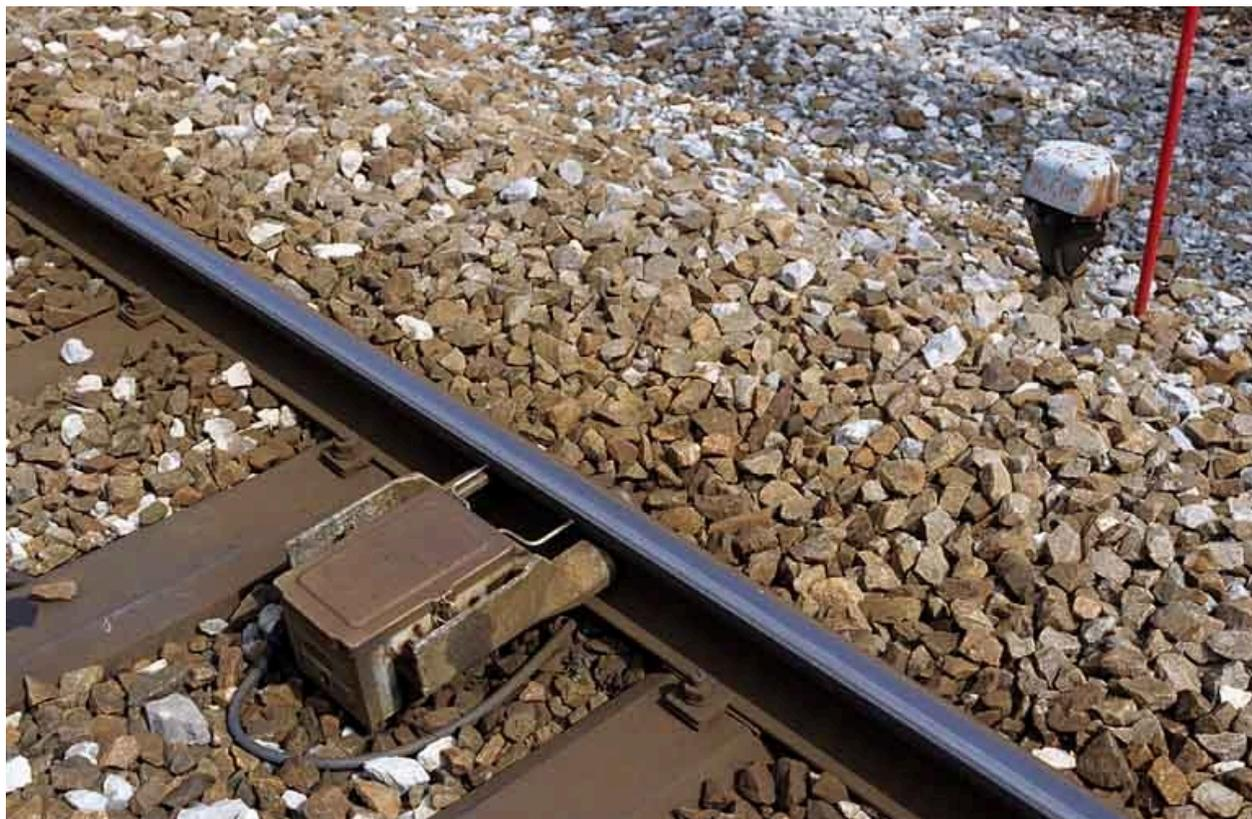
Pédale électromécanique Forfex : vue d'ensemble. Associée à un " crocodile ", cette pédale commande l'annulation de sa mise en charge lorsqu'il est pris à revers.
