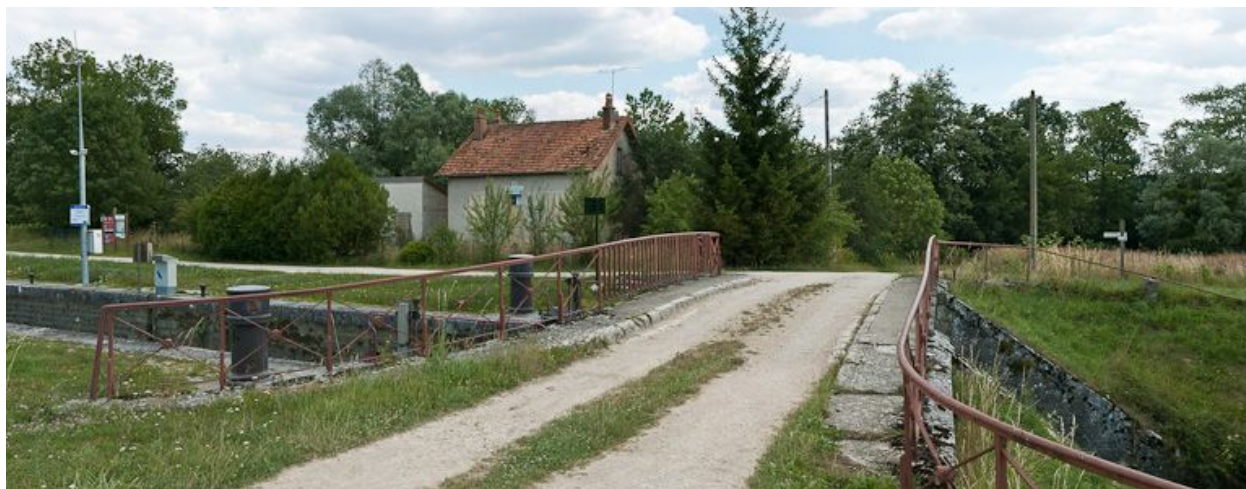
Vue d'ensemble du site d'écluse.
