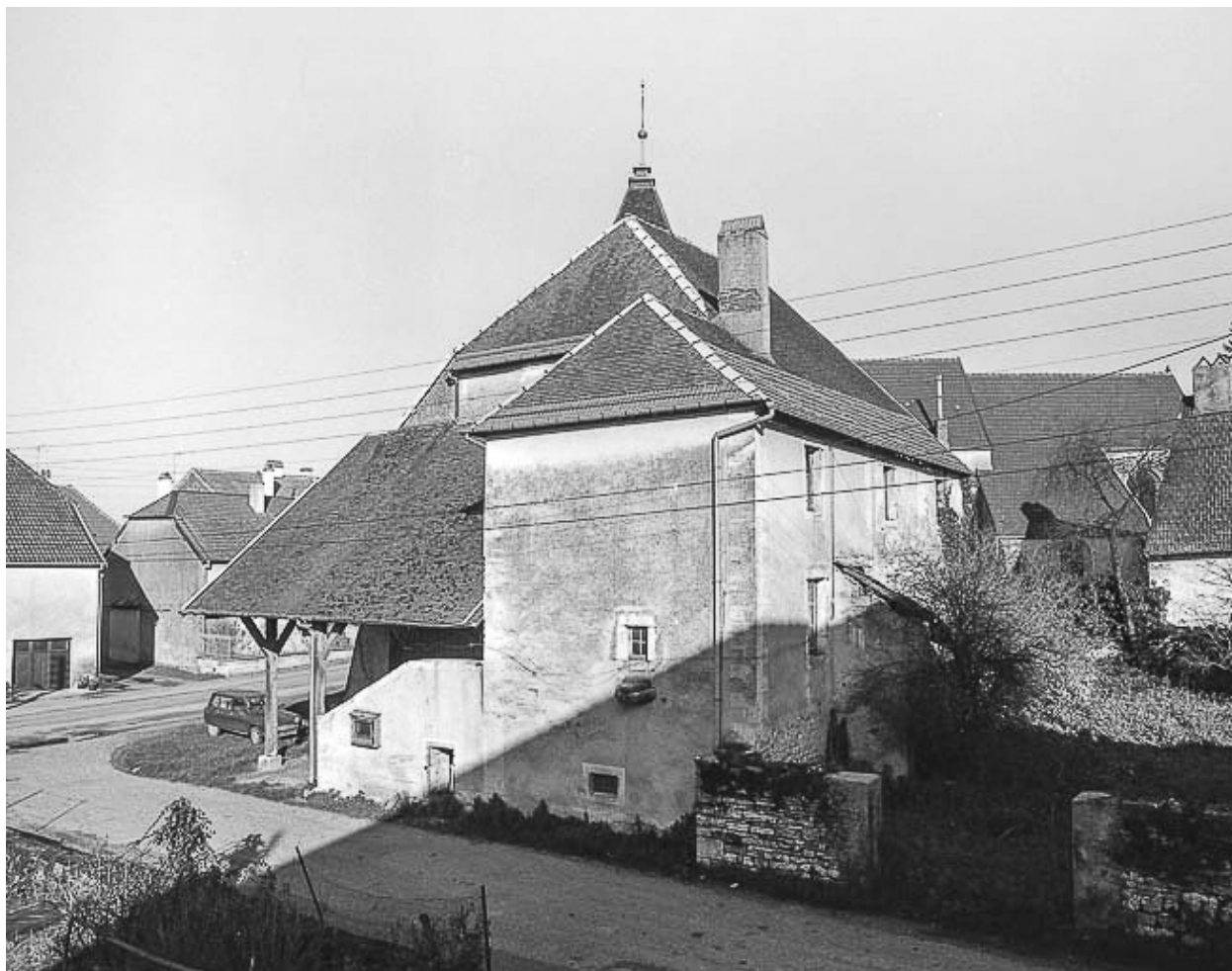
Façades postérieure et latérale droite en 1984.
