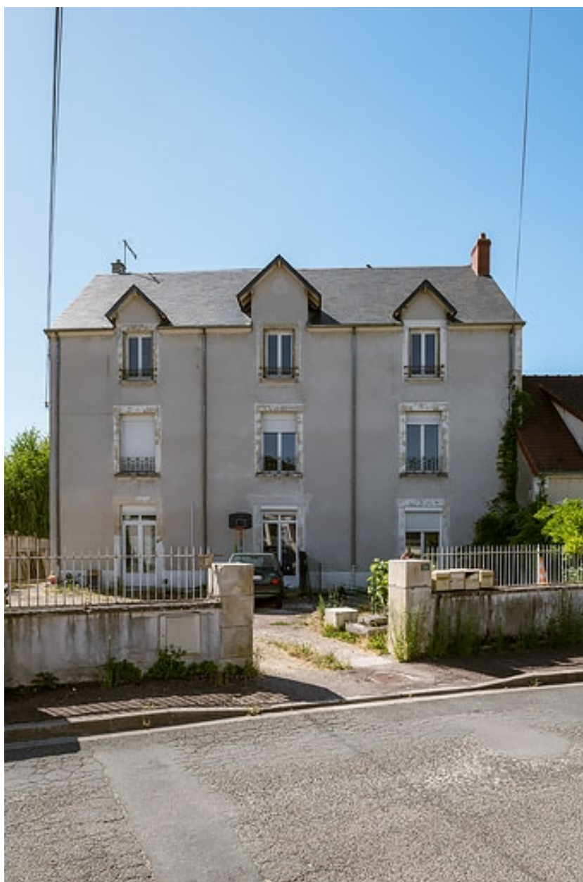
Façade depuis la rue de Bourgneuf.
