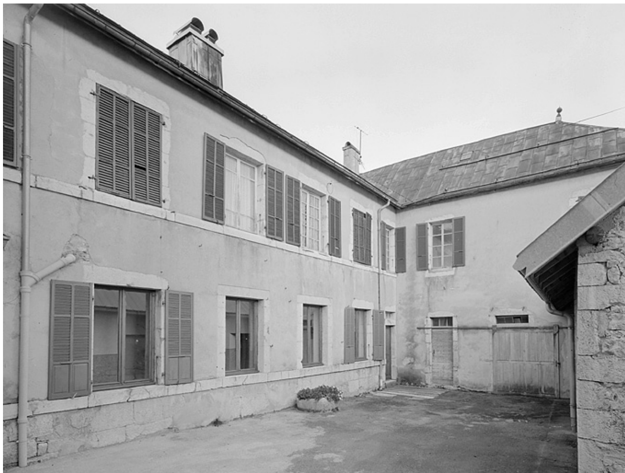
Cour intérieure : logis de la cure.
