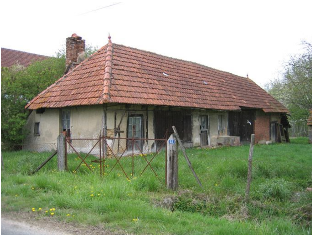
Vue d'ensemble de la façade.
