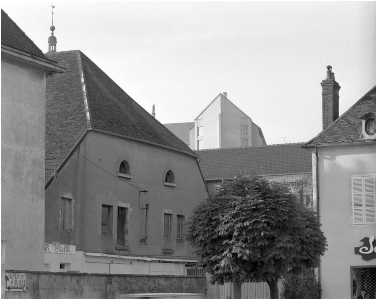
Détail du premier étage de la façade antérieure de l'entrepôt commercial.
