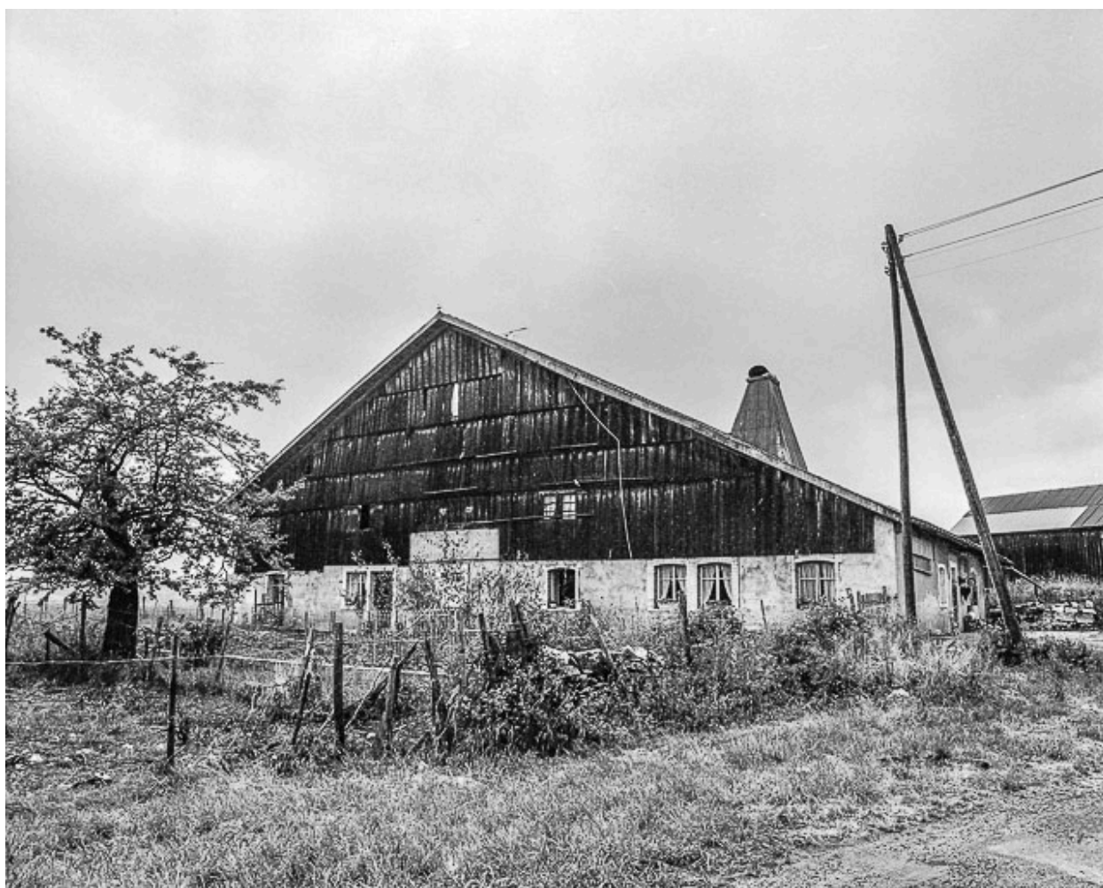
Ferme située au lieu-dit Combe d'Abondance, cadastrée B2 249 : vue d'ensemble.
