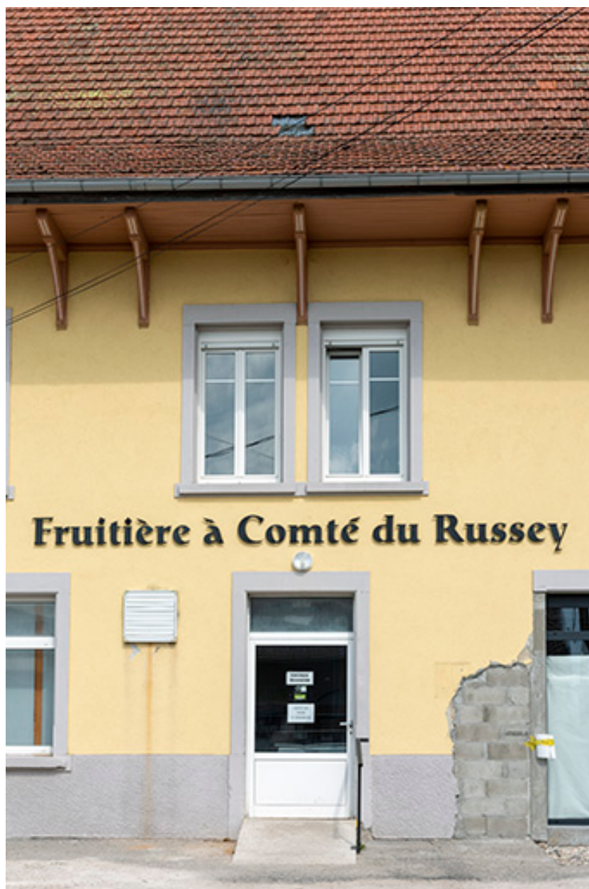
Façade antérieure : travée centrale.
