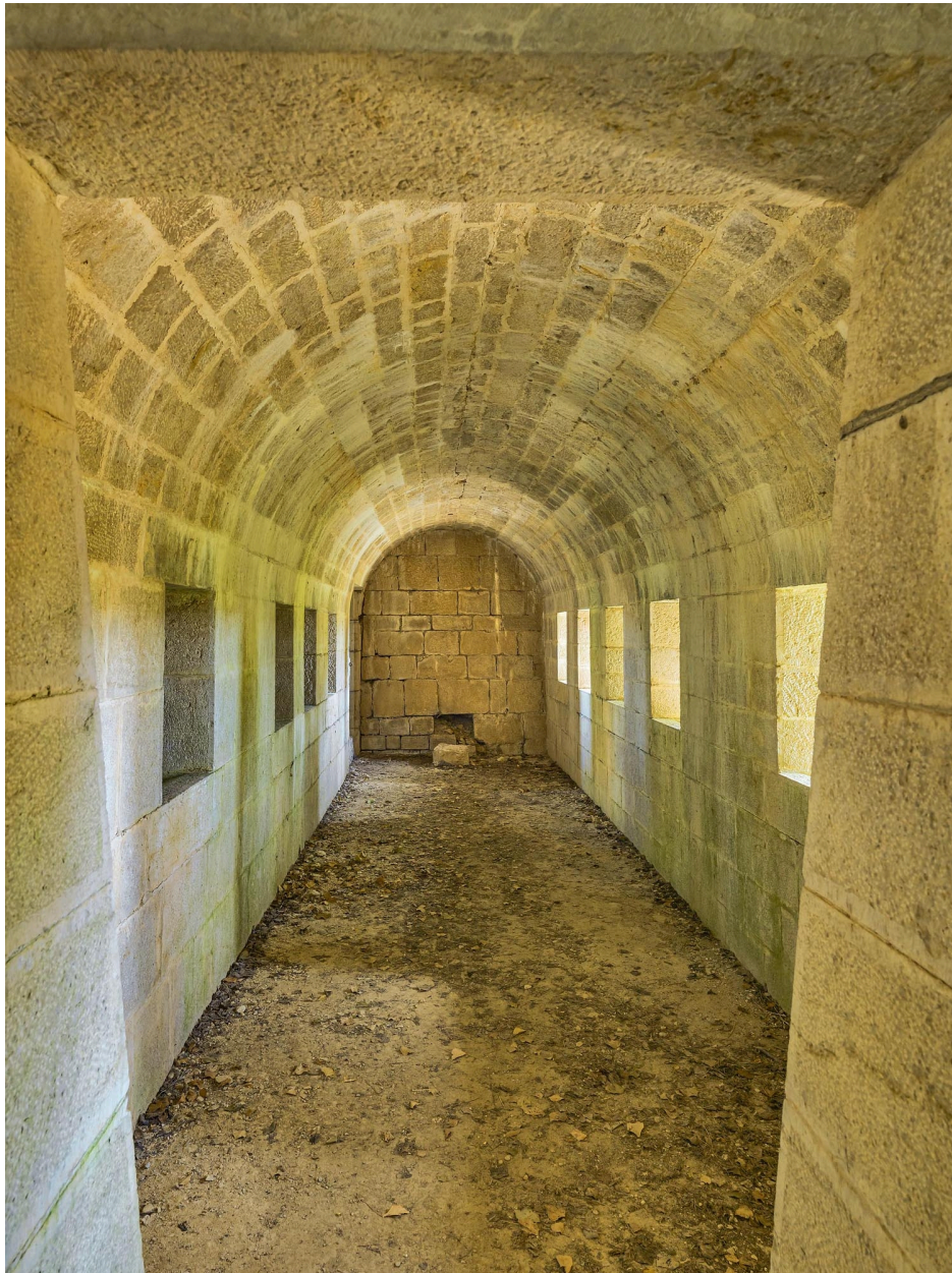
Caponnière flanquant l'intérieur du fossé.
