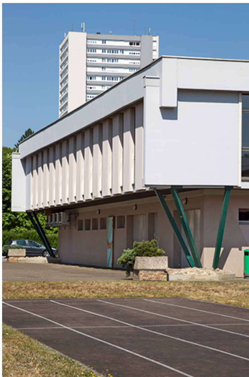
Pignon sud de la cantine.
