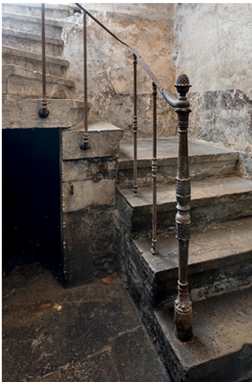
Chaudronnerie : rampe d'appui de l'escalier, au sous-sol.
