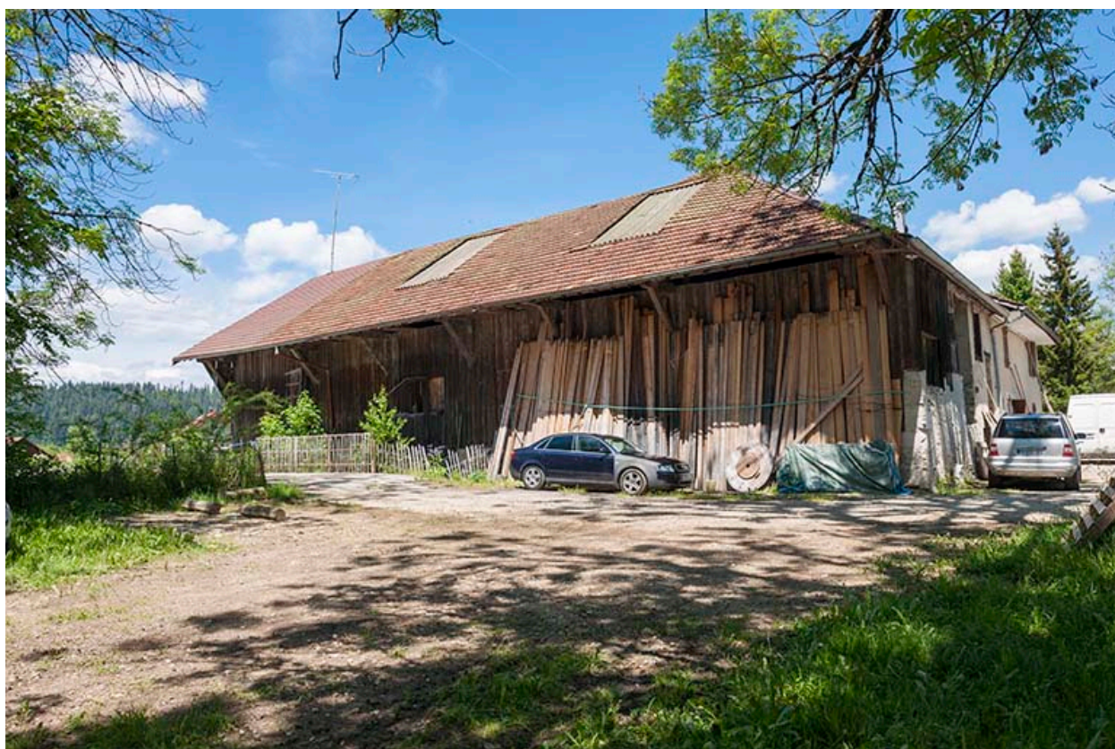
Atelier de scierie vu depuis le sud-est.
