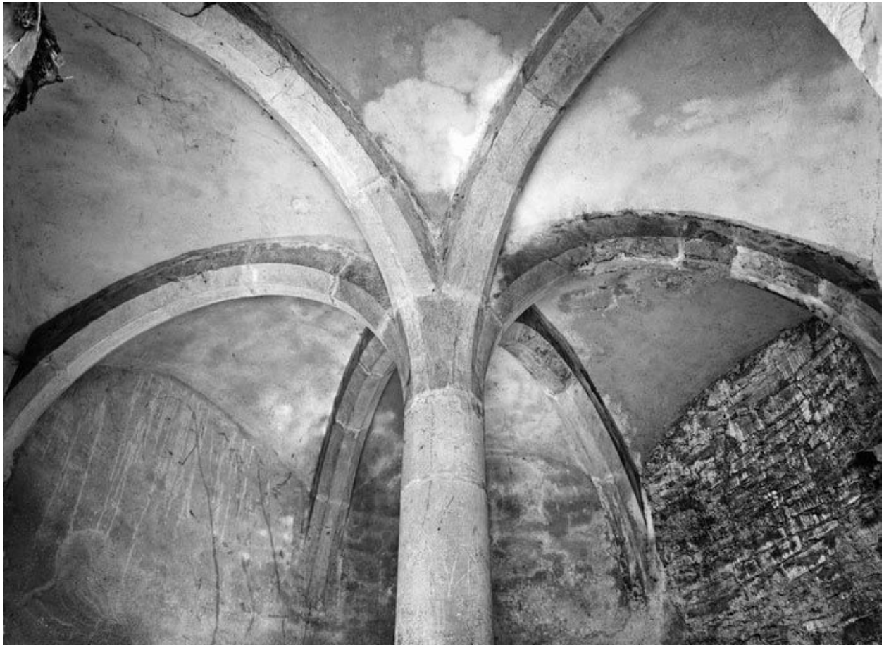
Tour Blondeau, casemate inférieure, détail : voûtement.
