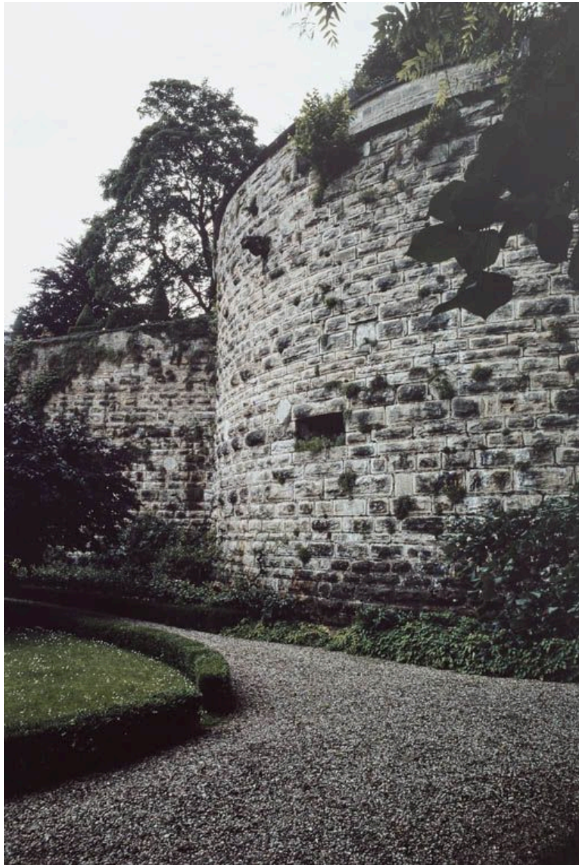
Courtine sud et tour sud-est depuis le fossé (1988).
