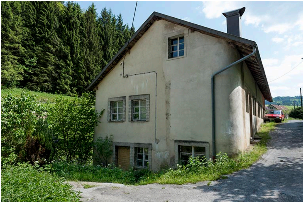
Usine : façade latérale gauche, de trois quarts droite.
