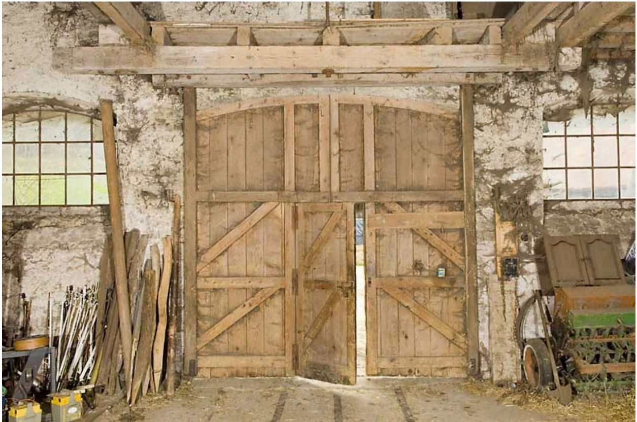
Grange haute : porte vue de l'intérieure.
