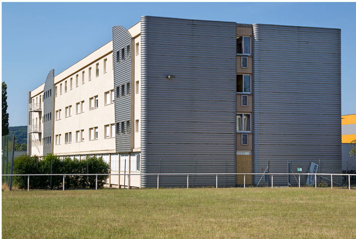
Pignon nord de l'internat.
