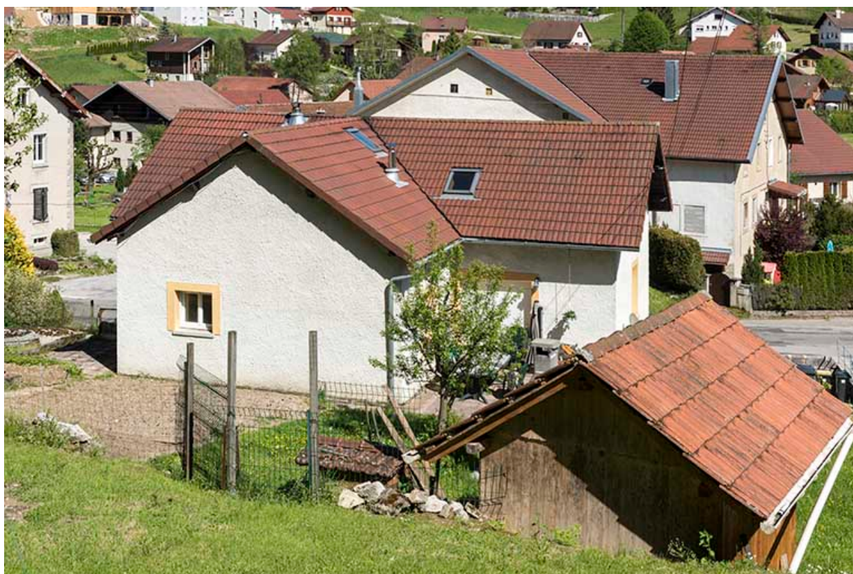
Façade postérieure (vue plongeante).
