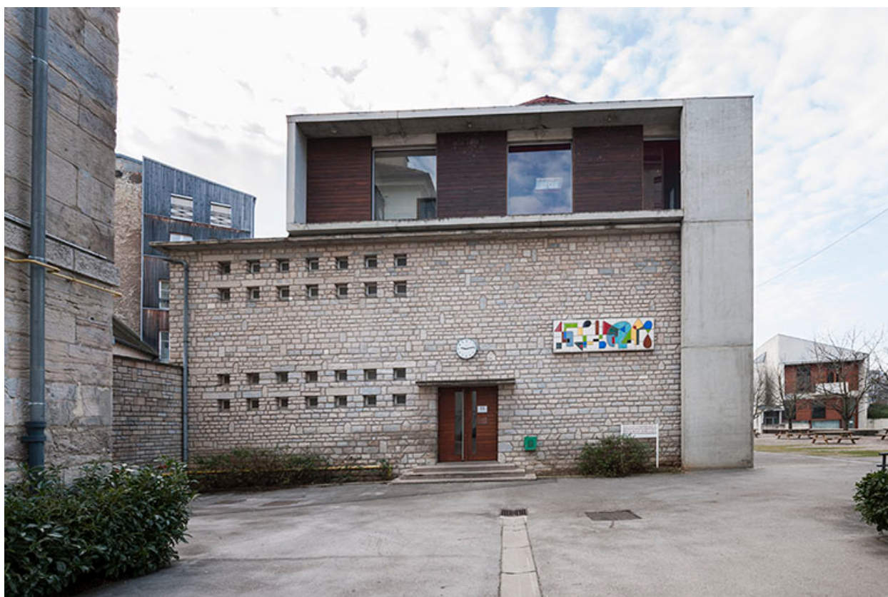
Le pignon nord de l'externat.
