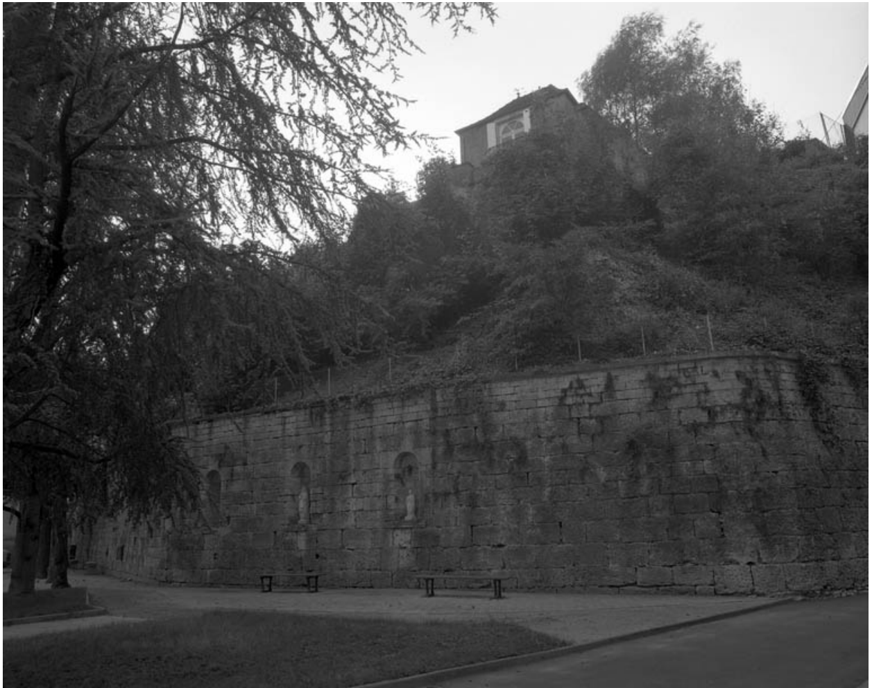
Restes du rempart du bastion du Boulevard dans la cour de l'hotel-dieu : angle de la partie inférieure.
