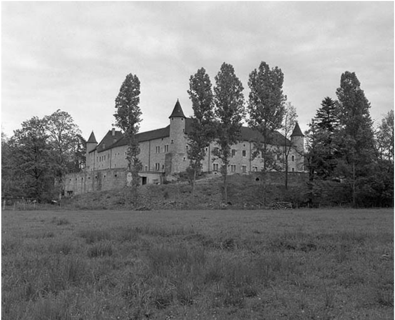
Façades nord et ouest.
