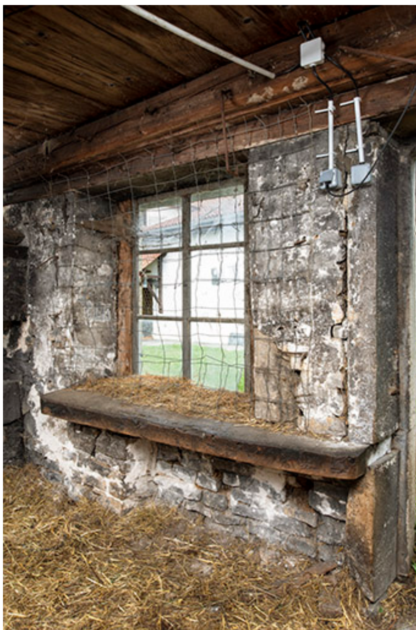
Forge nord : fenêtre et établi.
