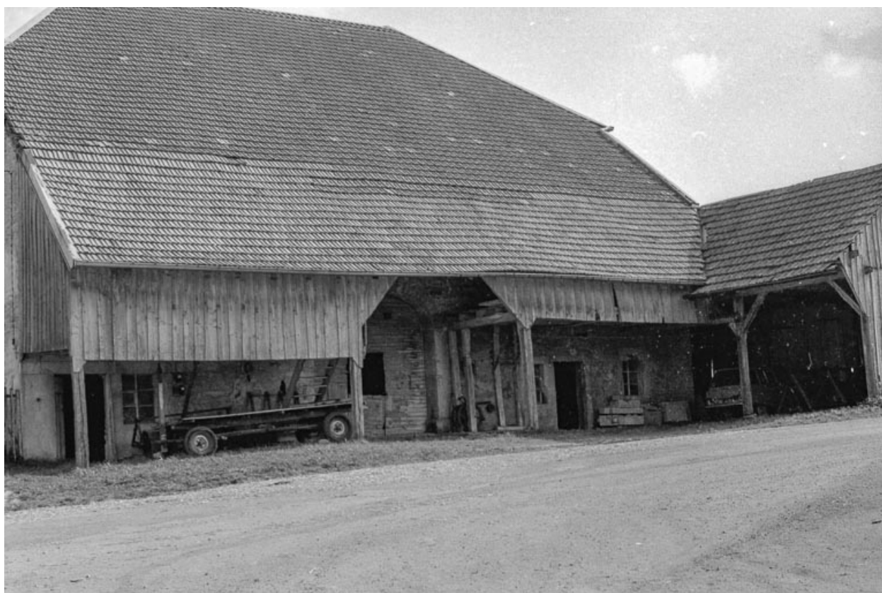
Ferme cadastrée 1945 d 154-155 : façade postérieure.
