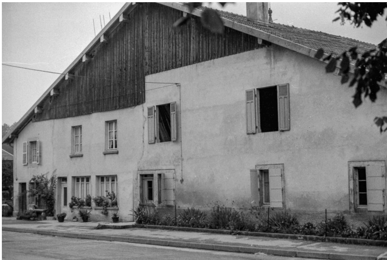
Ferme cadastrée 1939 F 183-184 : façade antérieure.
