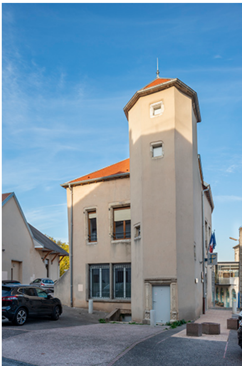
Détail de la tour d'escalier.
