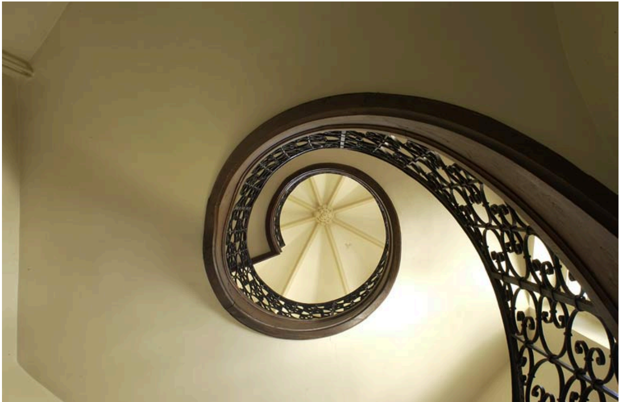
Escalier en vis néo-gothique desservant la partie sud de l'aile orientale (vue prise du rez-de-chaussée).
