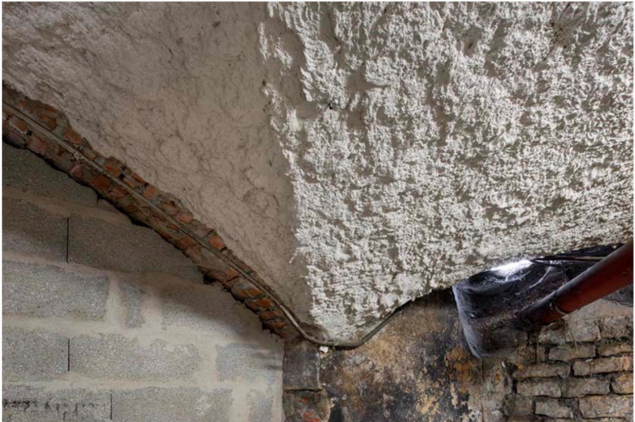
Bâtiment Proudhon : détail de la voûte d'arêtes d'une salle au sous-sol.
