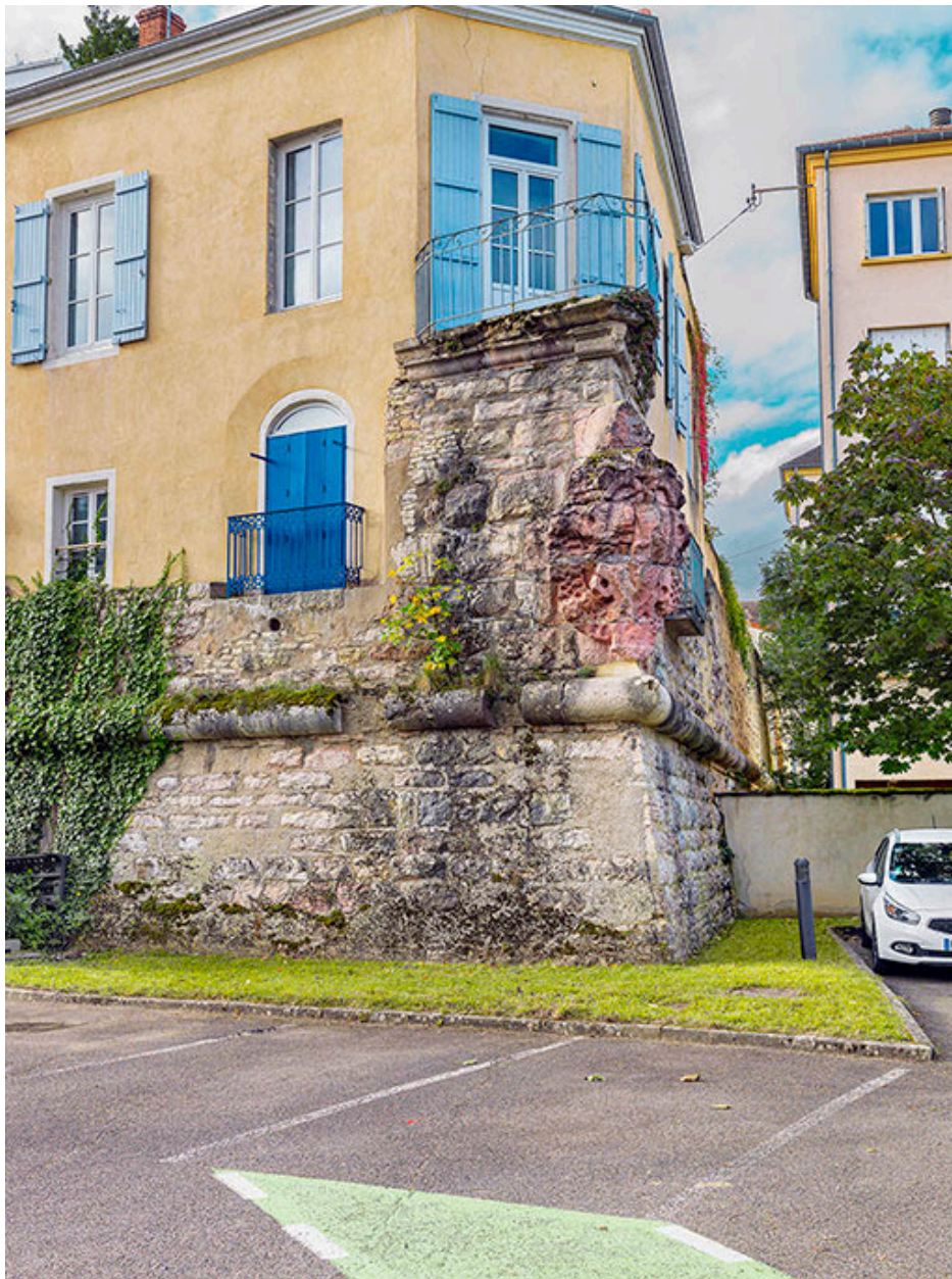
Angle du bastion Saint-Pierre.
