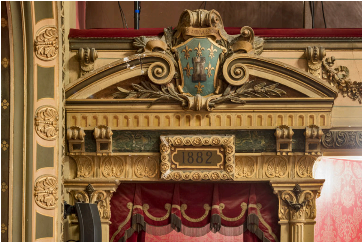
Loges d'avant-scène, côté cour : couronnement.
