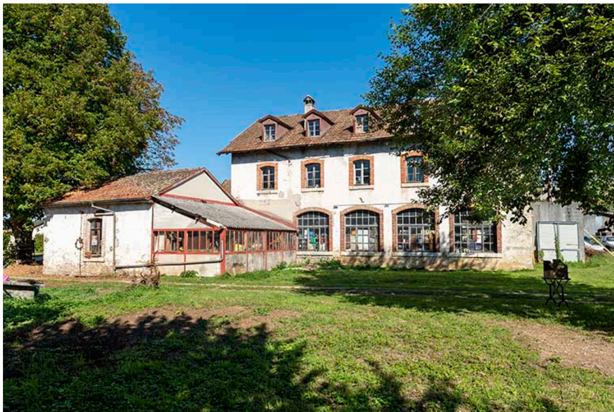
Usine d'outillage Hugoniot-Tissot puis Hugoniot-Perrenoud dite la Fabrique, Montécheroux (31-33 rue de Saint-Hippolyte).
