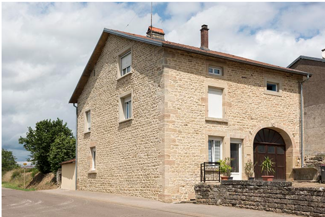
Ferme bloc chemin de Seroux.
