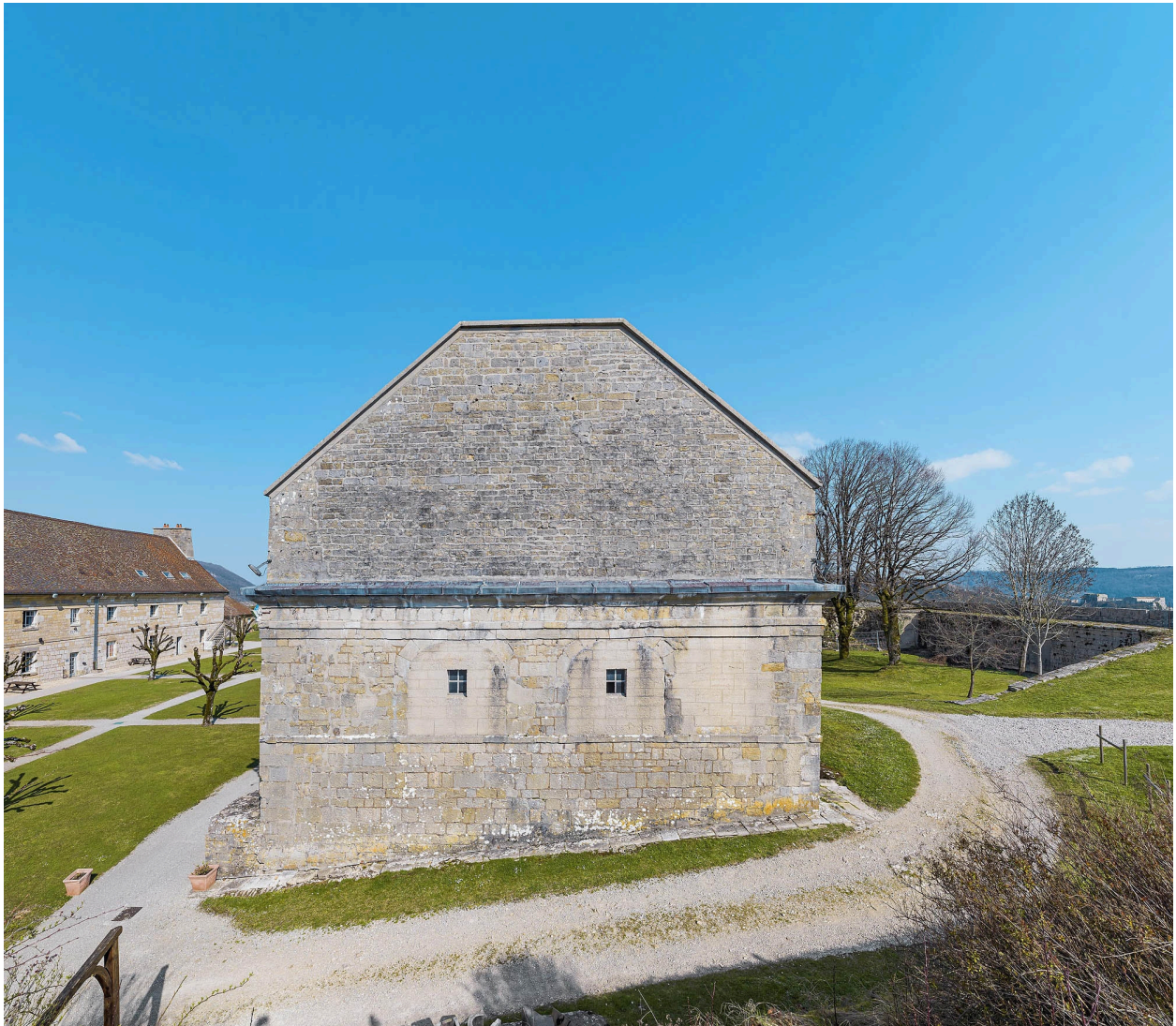
Caserne V : Mur pignon.
