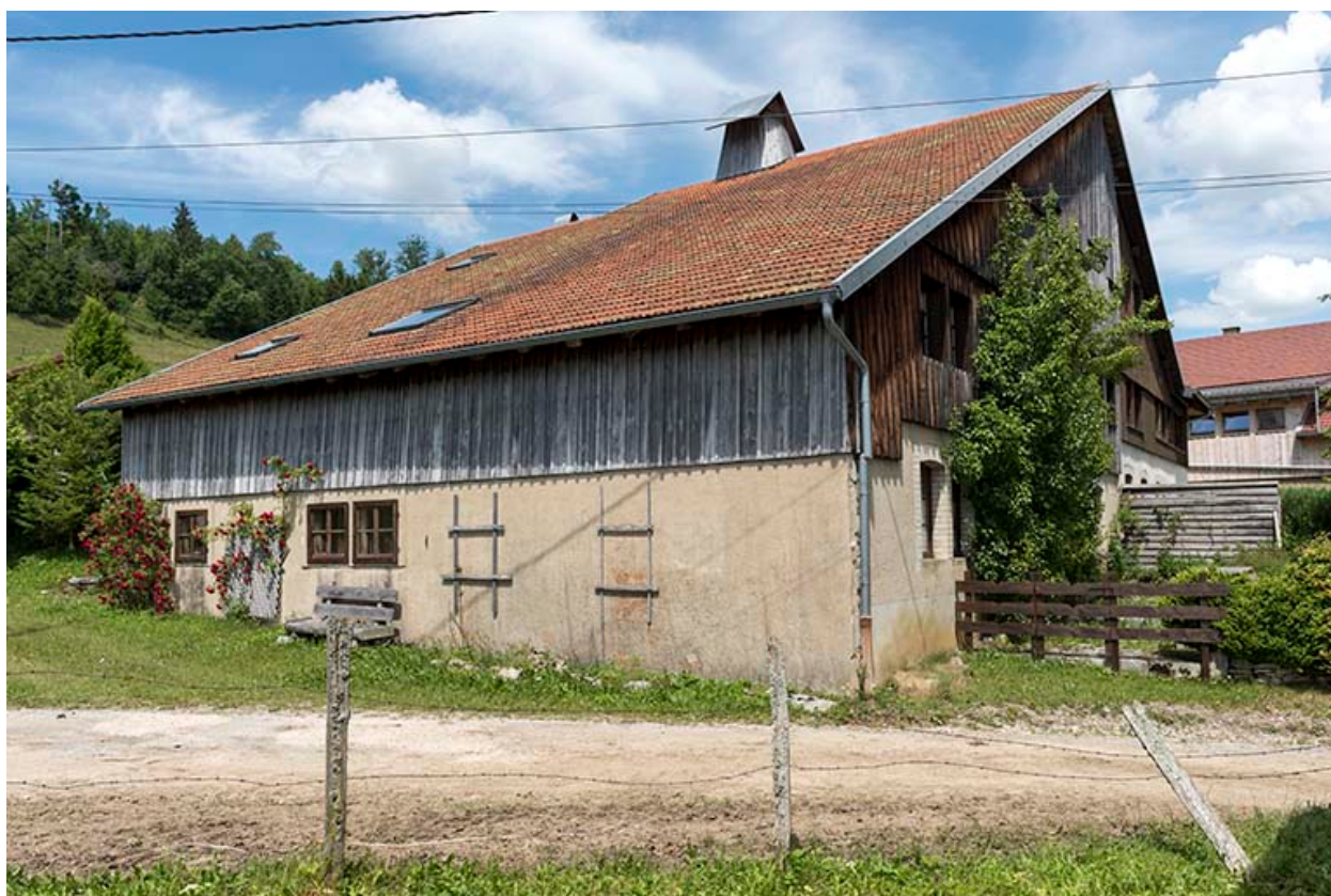
Façades antérieure et latérale gauche.
