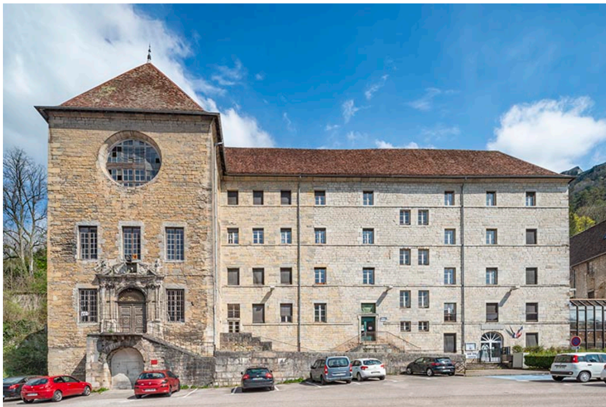
Vue rapprochée depuis l'ouest.
