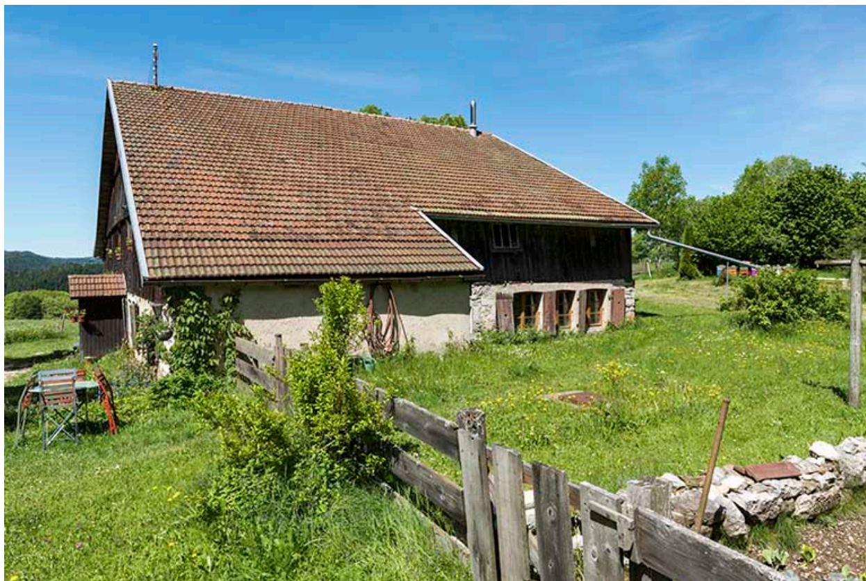
Façade latérale droite.
