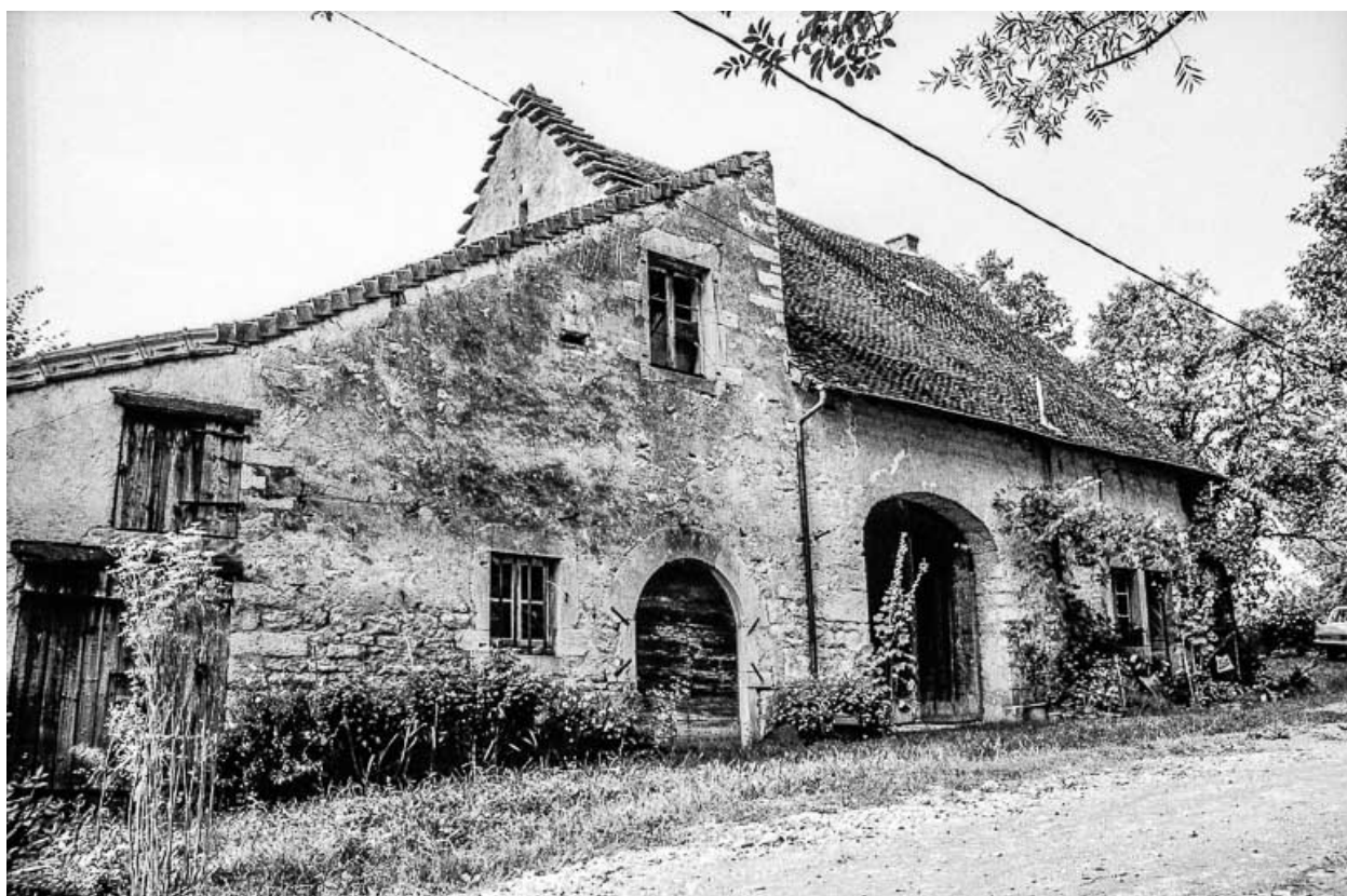
Ferme cadastrée 1964 AC 48 : vue d'ensemble.
