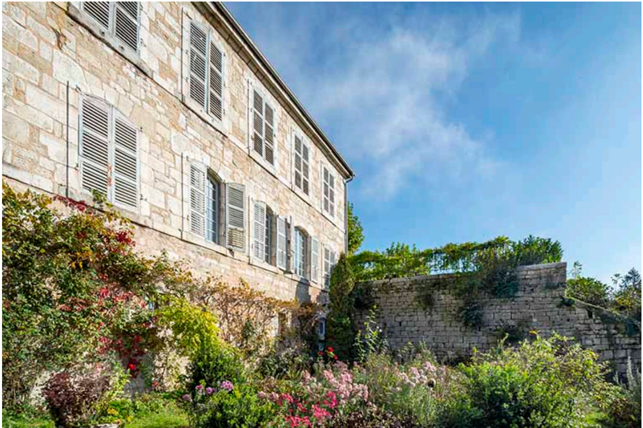
Façade ouest vue de trois quarts droite.
