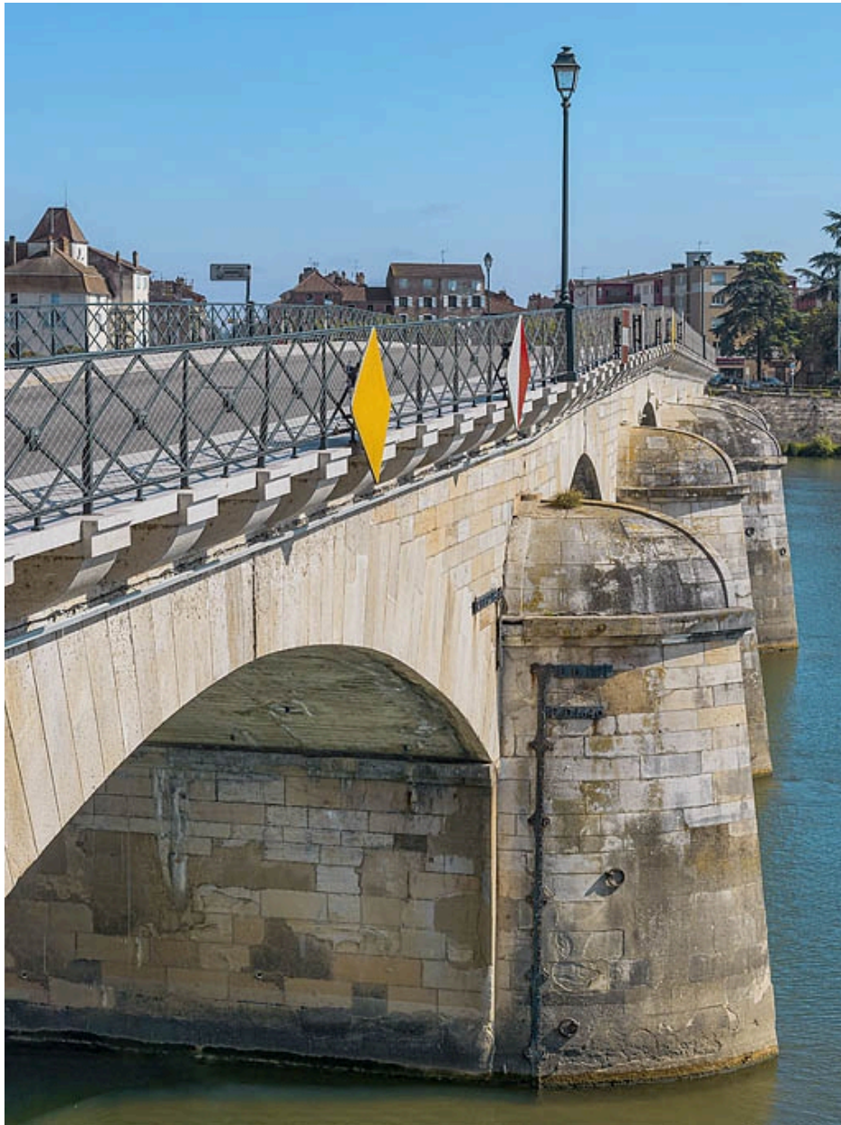
Détail des arrière-becs du pont.
