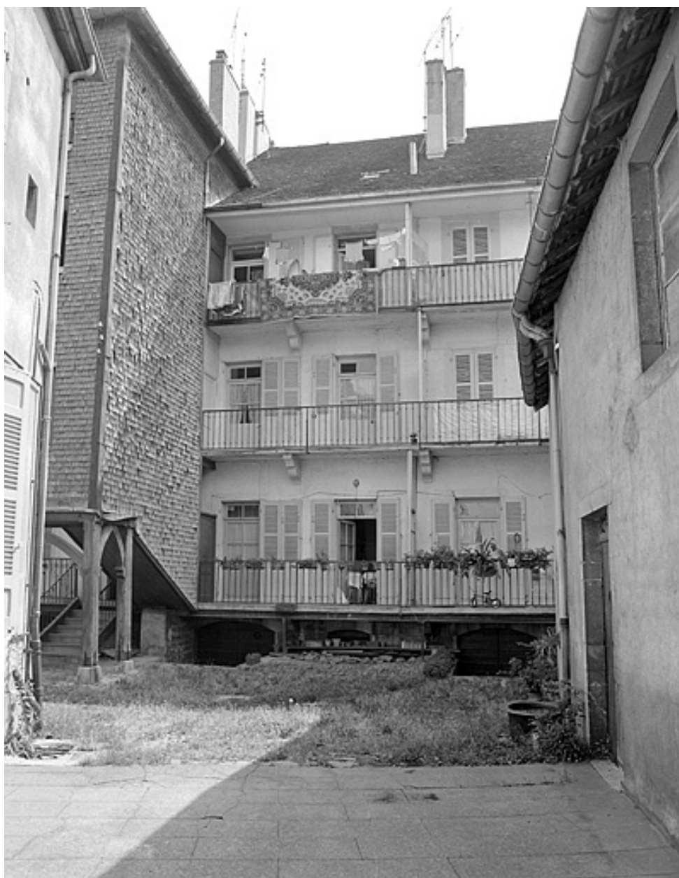
Façade postérieure montrant l'escalier à gauche.
