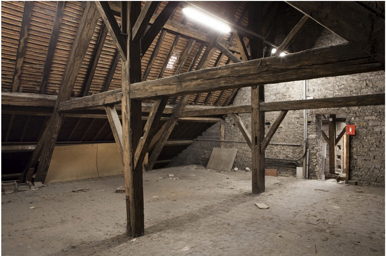
Intérieur, comble : détail de la charpente.
