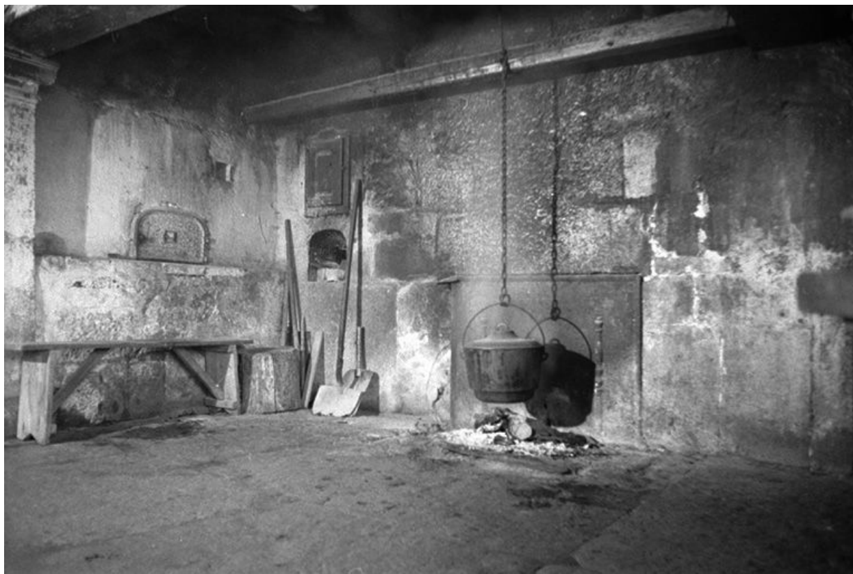
Cheminée et four de la cuisine.
